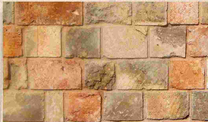
Particolare del rivestimento esterno
